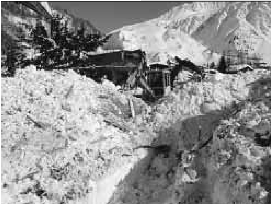
Dégâts dans le hameau de Montroc provoqués par l'avalanche du 9 février 1999. (Photo Météo-France, Yannick Giezendanner)
